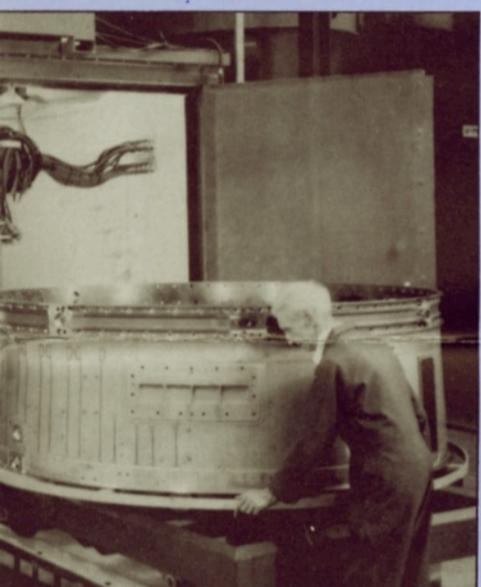
La préparation de surface de pièces essentielles de la dernière version du moteur Rolls Royce RB211 avant collage et peinture a été totalement modernisée par l'installation d'une machine Vacu-Blast, voie sèche, programmable.
